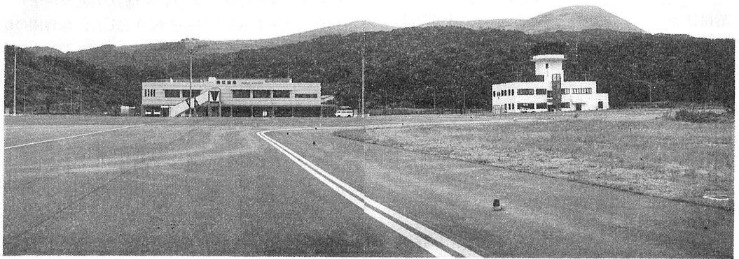
写真-2 福江空港新旅客ターミナルビル（エプロン側より）
