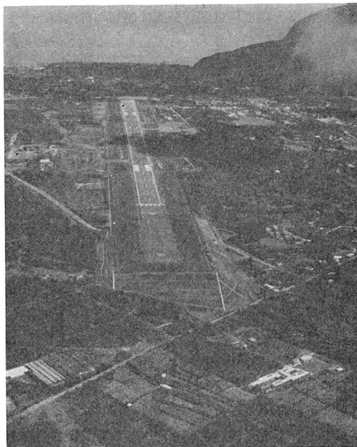
写真-1 滑走路延長部分（手前）
